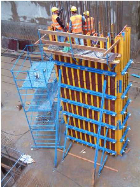
Plamax Pro 21mm Çelik Kuşak ve H20 Sistem Dikey Kalıp Uygulaması.
