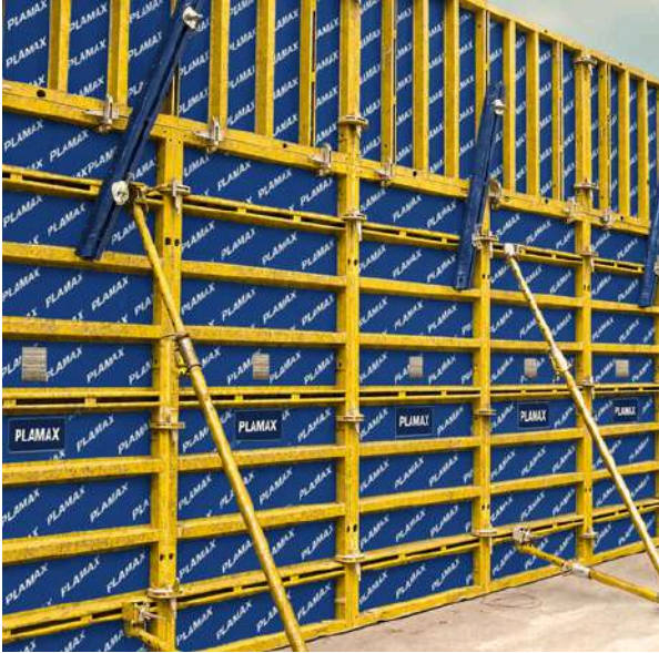
Plamax Nova 21mm Panel Kalıp Perde Beton Döküm Uygulaması.
