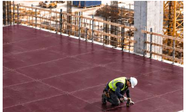
Plamax Pro 9mm Alüminyum Sistem Döşeme Kalıp Uygulaması.
