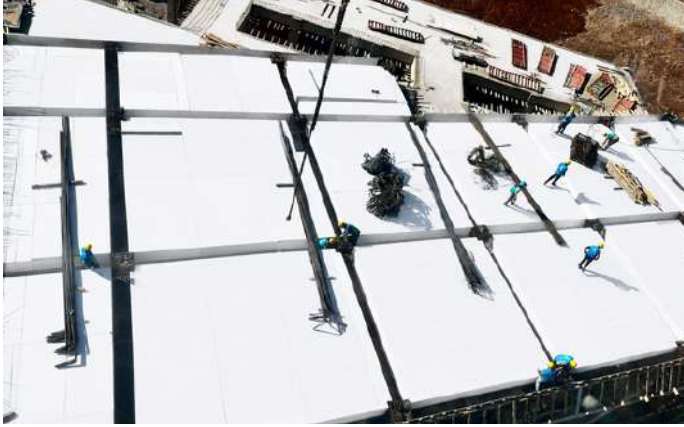
Plamax Eko 18mm Döşeme Kalıp Uygulaması.
